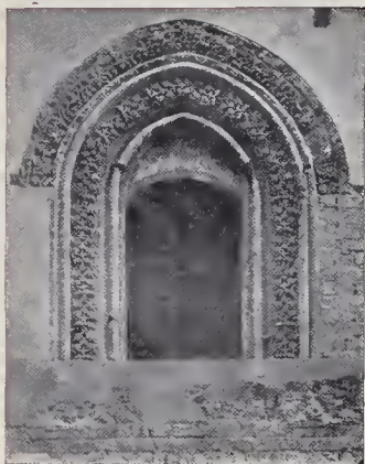
Finestra di una casa in via dei Mercanti.
